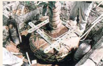
3 接続金具を付けてベルトで固定 抵抗板、ベルトフックを取り付けてください。
