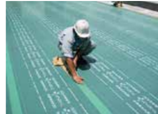
①耐根シート敷設
