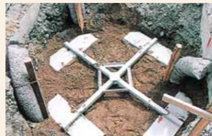
1 アンダーベースをセット 抵抗板、ベルトフックを取り付けてください。
