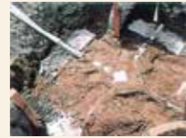
2 樹木をアンダーベースの上に載せて上面プレート 根鉢の下側面に土を戻し、樹木を自立させてから作業してください。
