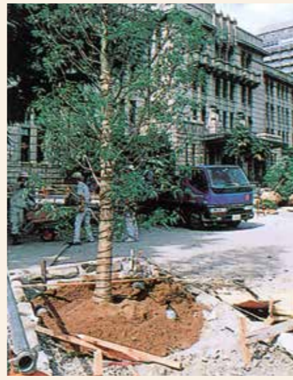
2 樹木をアンダーベースの上に載せて上面プレート 根鉢の下側面に土を戻し、樹木を自立させてから作業してください。
