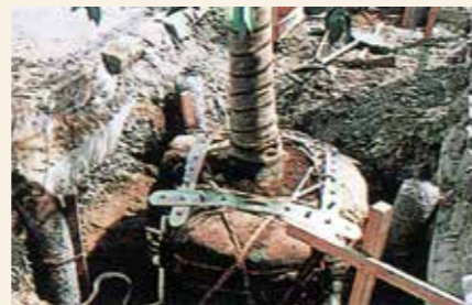
4 土を埋め戻し完了
