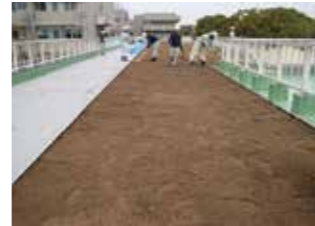
⑤人工軽量土敷き均し
