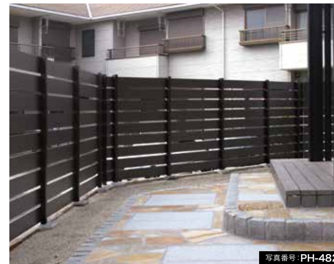
写真番号: PH-482 エイコープラボード Dブラウンを使ったフェンス施工例
