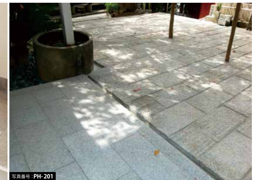
▲広い敷地内でも板石パーナーと板石のみぎりの使い分けで、濃淡のある敷地に生まれ変わります。
