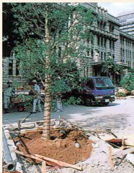
4 土を埋め戻し完了
