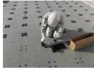
③専用ジョイントでマットを連結
