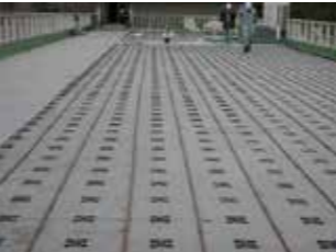
④点滴チューブ設置
