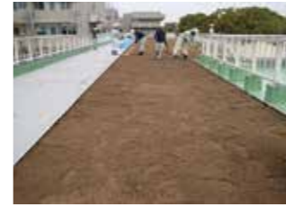
⑤人工軽量土敷き均し
