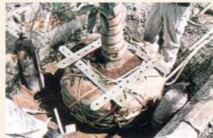
2 樹木をアンダーベースの上に載せて上面プレート 根鉢の下側面に土を戻し、樹木を自立させてから作業してください。
