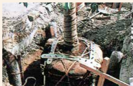
3 接続金具を付けてベルトで固定
