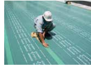
①耐根シート敷設
