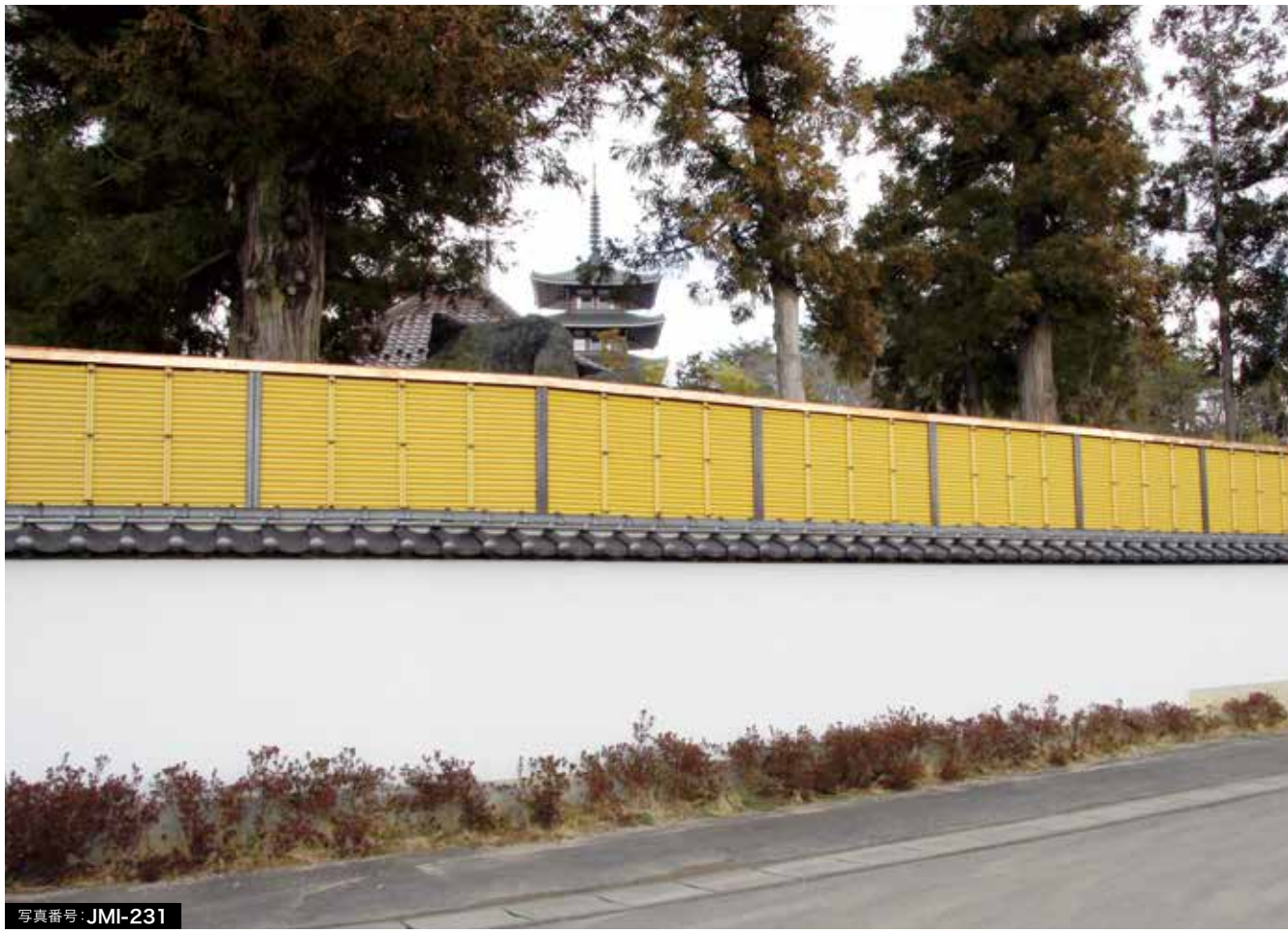
エイコーポール(イエロー・38φ)とC型アングルで組み立てた御簾垣(創作垣)、屋根には銅板をのせています
