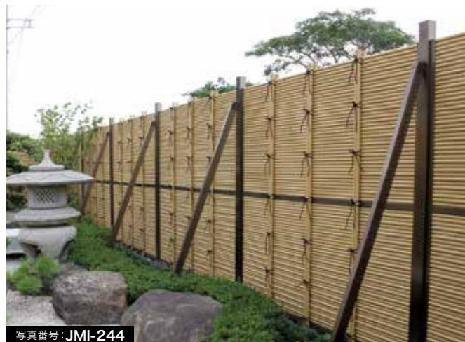
風の強い地域での御簾垣の施工例
