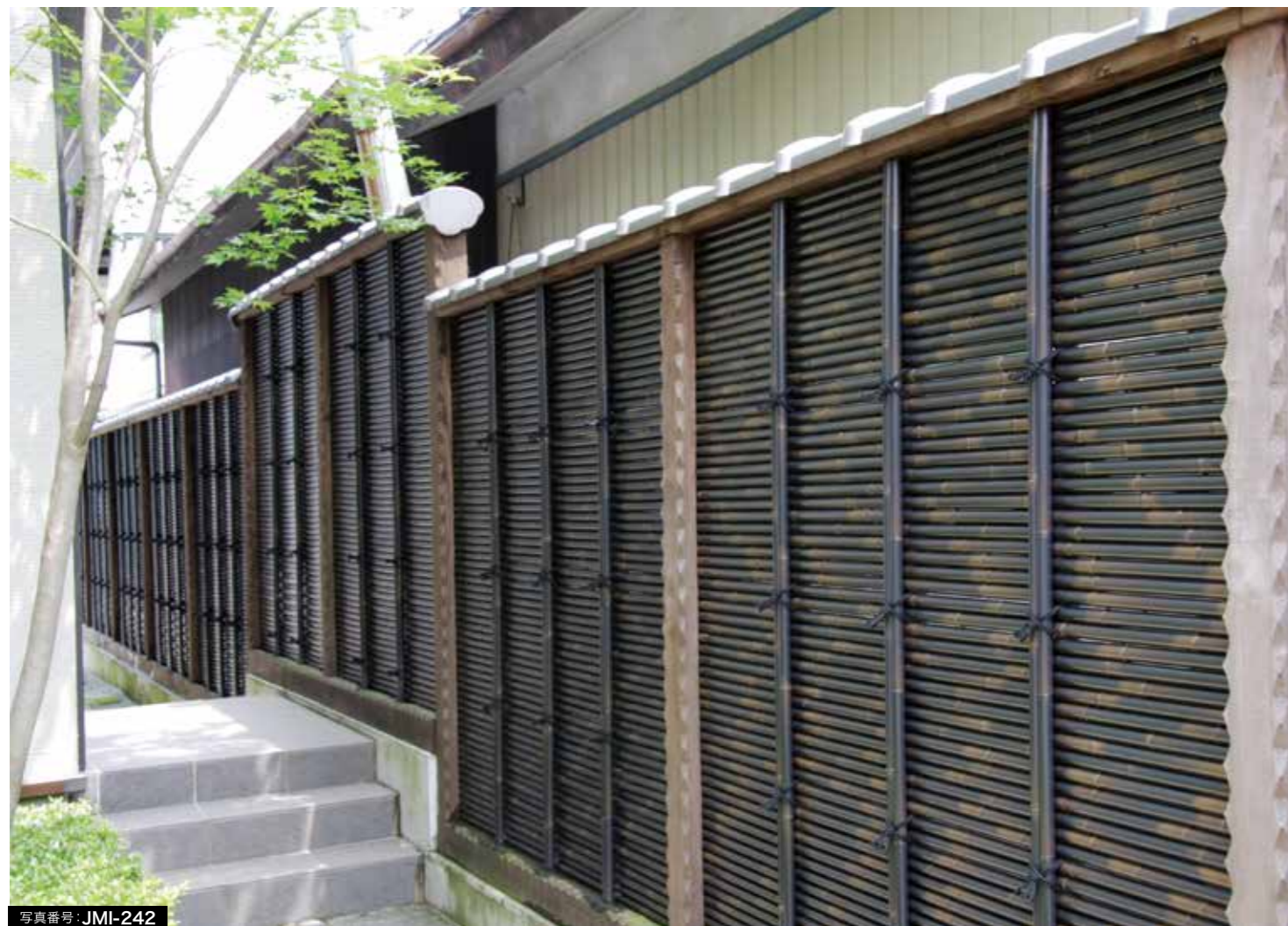
栗の木をノミで削った支柱にエイコーポール(黒竹匠・22φ)で御簾垣を組立てて、屋根には日本瓦を施した創作垣
