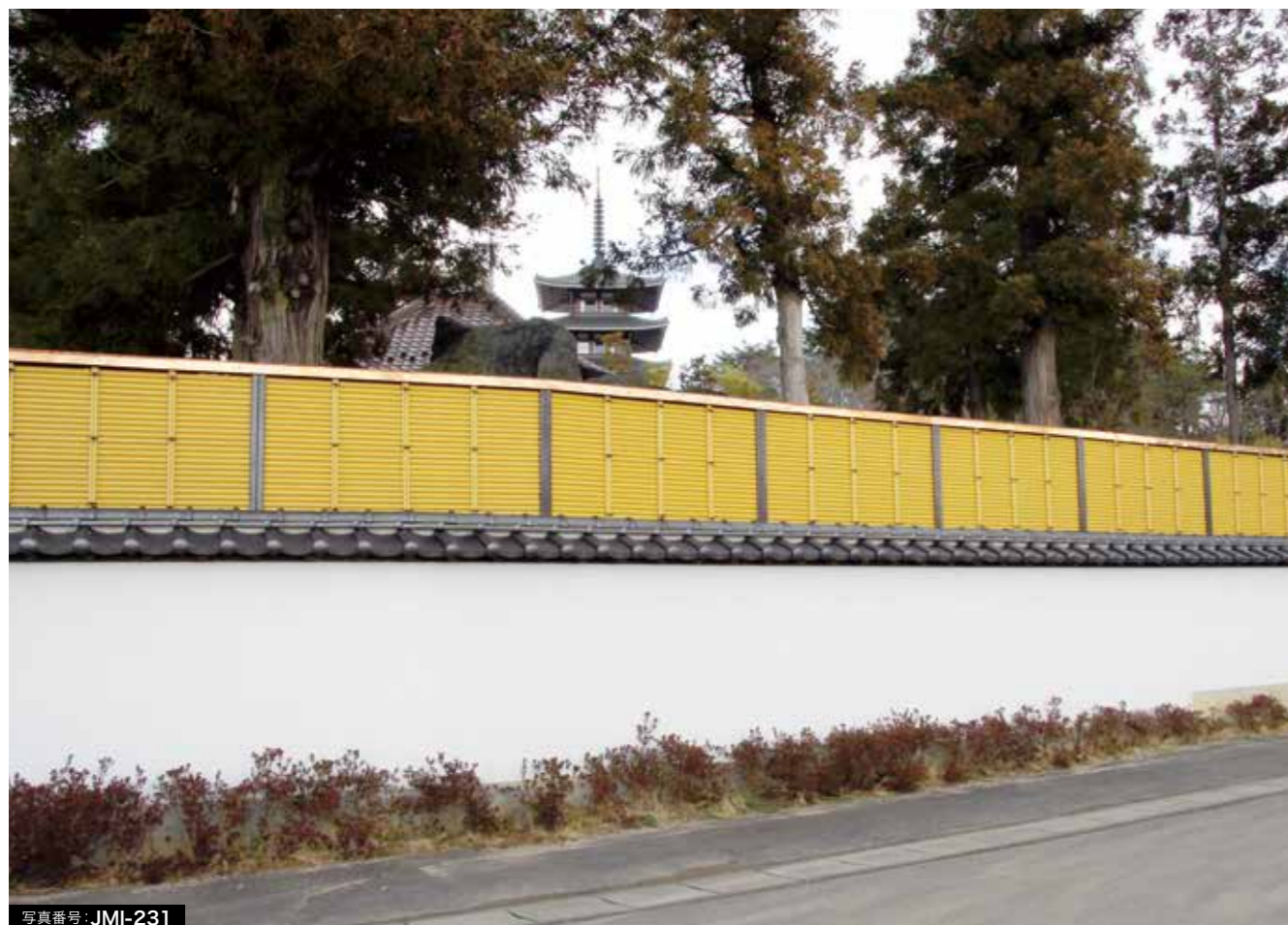
エイコーポール(イエロー・38φ)とC型アンクルで組み立てた御簾垣(創作垣)、屋根には銅板をのせています
