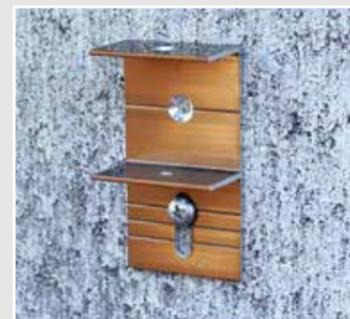
アルミ胴縁22壁貼用Fアングルをコンクリート用ビスピタ又はモンゴプラグビスで壁に固定してください。
