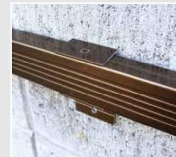
アルミ胴縁22をアルミ胴縁22壁貼用Fアングルに差し込み、付属のビスで上下を止めてください。
