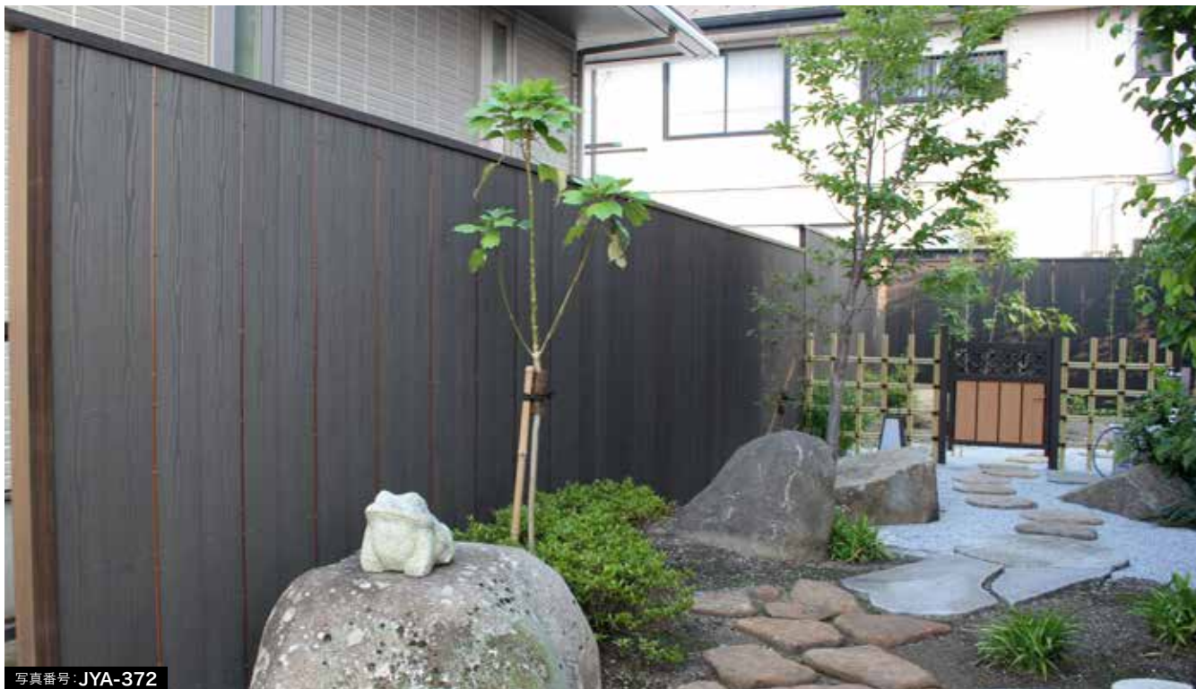
杉板よしのブラック・ボール13φ煤竹匠堅板張四ツ目垣を施した人工竹入板張木戸
