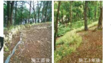
施工から3年経過した現場で、笹はエリア外へ浸食しておらず、防根シートによって完全に抑制されていた。
