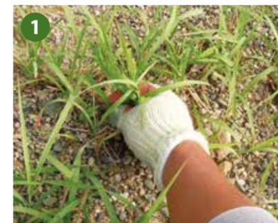
1 施工面の雑草を除去。根も抜き取って下さい。
