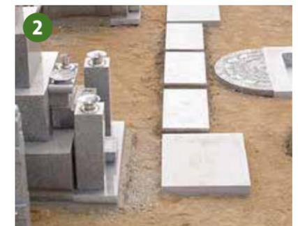
2 施工場所 (下地) の整正。(スリ取りを3cm以上にして下さい。)
