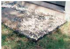
2 小回りのきく500mmピッチのプレートで施工ラインに沿ってジョイントしていきます。
