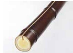
▲施工後の割れを防止するため、背割れを施します。竹の内壁と発泡ウレタン樹脂が強く接着されるので、樹脂充填を施さない竹の背割りよりも背割り部の開きは格段に抑制されます。
