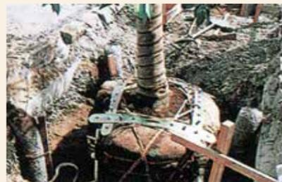
**3 接続金具を付けてベルトで固定**
